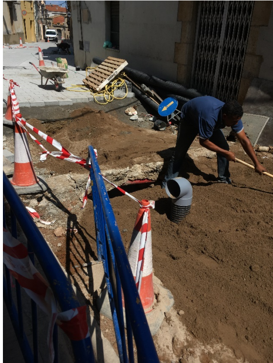
Pavimentació definitiva tram c. Girona- c. Roscada
