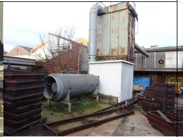
Imatge 14: Filtre d'aspiració i sistema d'extracció de fums de l'establiment
