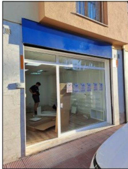
FAÇANA PRINCIPAL EXISTENT
