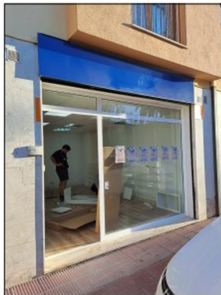
FAÇANA PRINCIPAL EXISTENT
